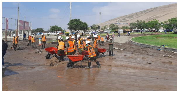
Figura 7: Limpieza del ingreso a la ciudad de Tacna, tras el deslizamiento de lodo y piedra, a comienzos del 2020. Fuente: Oficina de Informaciones del Ejército.
