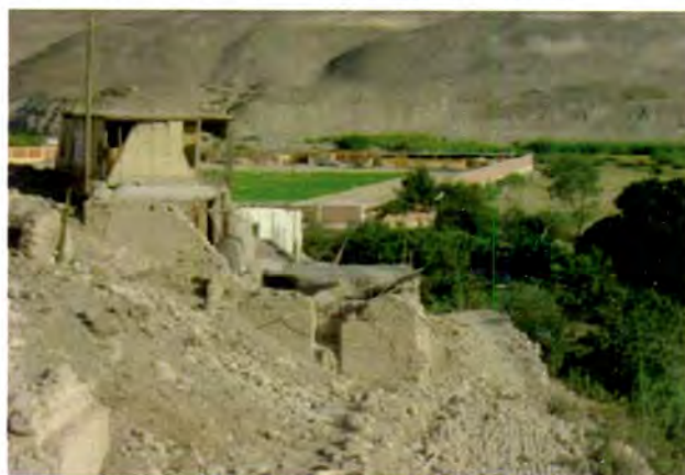
Figura N°06. Bodega adyacente a una vía
