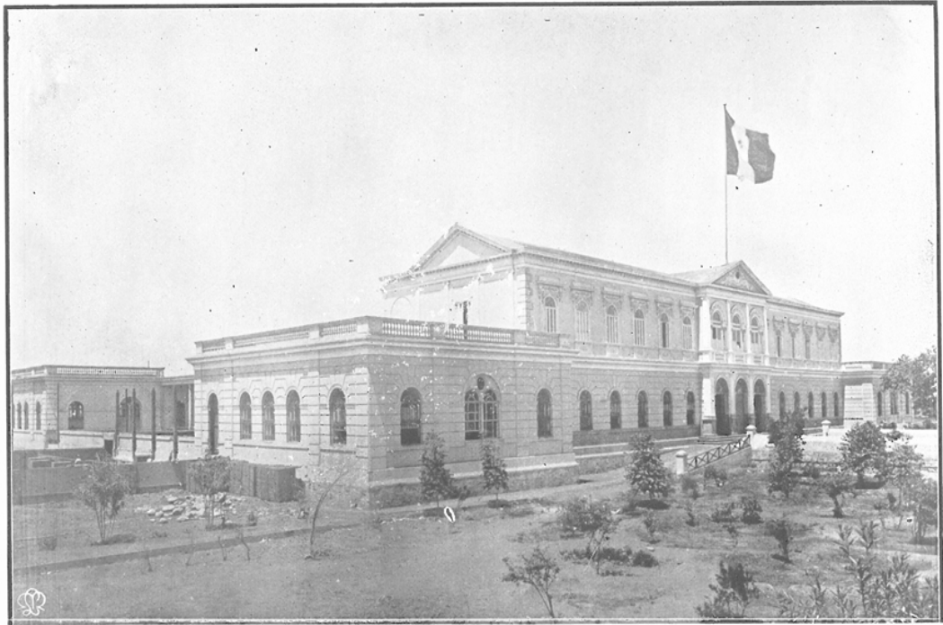
FACHADA DE LA ESCUELA DE ARTES Y OFICIOS
