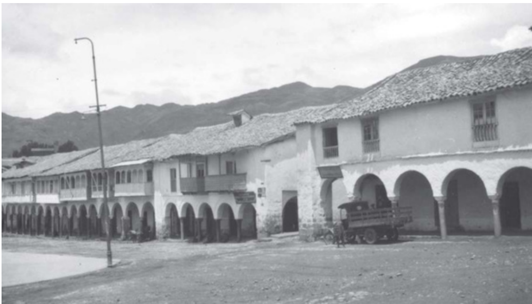
Fuente: Jorge Flores Ochoa (2005). Foto del Portal de Panes.
