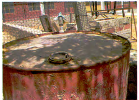
Figura 5: Elevación de Tapa de Biodigestor 1
