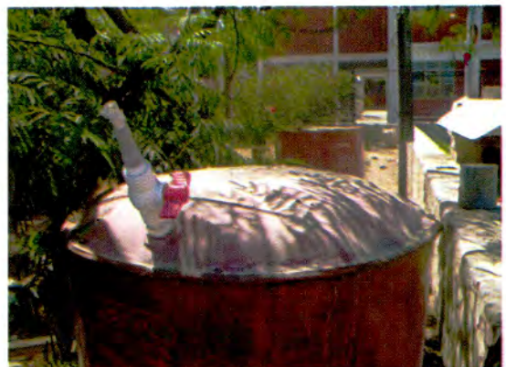
Figura 6: Elevación de Tapa de Biodigestor 2
