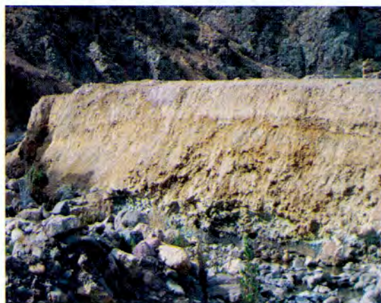
Material lixiviado por acción de la lluvia.
